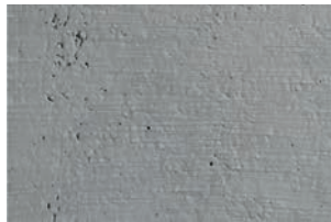
Tehnica beton aparent brut
