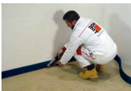
1. Montarea benzilor de etanșare
