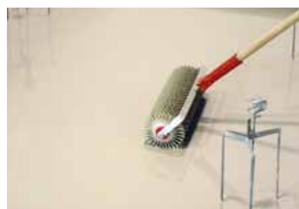
6. Dezaerarea suprafeței cu rolă cu țepi
