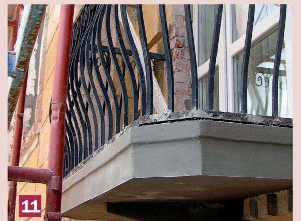
11 Se va proteja de o uscare prea rapidă, de exemplu se va acoperi cu folie din PE. Apoi se va aplica vopseaua Nanopor pe părțile fațadei și pe partea inferioară a balconului.
