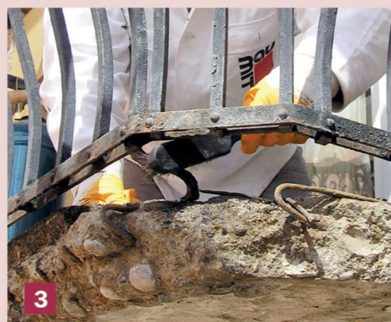
3 Betonul deteriorat se va curăța cu grijă în zona armăturilor până când se ajunge la o suprafață necorodată. Aderența între beton și armătură trebuie să fie foarte bună. Armătura se va peria cu o perie de sărmă până la luciu.
