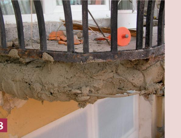
8 Mortar de reparații Baumit BetoFill poate fi aplicat într-un singur strat de până la 4 cm grosime. Se aplică BetoFill după amorsare în prealabil cu amorsa de aderență Baumit BetoHaft în umed, adică "umed pe umed". În cazul în care BetoHaft se usucă, acesta trebuie îndepărtat și aplicat un nou strat.
