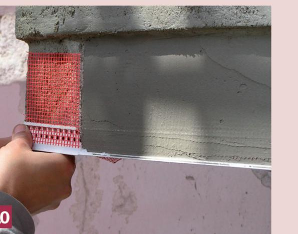
10 Prelucrarea finală a suprafeței se realizează plin aplicarea unei mase de spaciu Baumit BetoFinish într-un strat de 3-5 mm grosime. Pe latura inferioră se va fixa un profil lăcrimator Baumit Tropfkantenprofil. Partea superioară a balconului se va spaclui și arma cu masa de spaciu pentru betoane BetoFinish.
