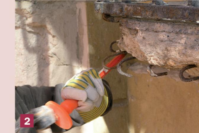
2 Suprafețele deteriorate se vor curăța cu dalfa și ciocanul. Vă rugăm să vă asigurați că betonul nedeteriorat nu este distrus. Suprafețele mai mari sunt tratate prin sablare.
