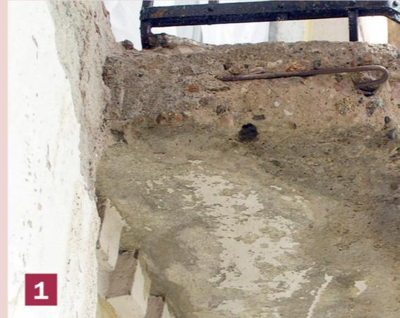
1 Balcoane cu deteriorări, armătura corodată și balustradă ancorată în suport.
