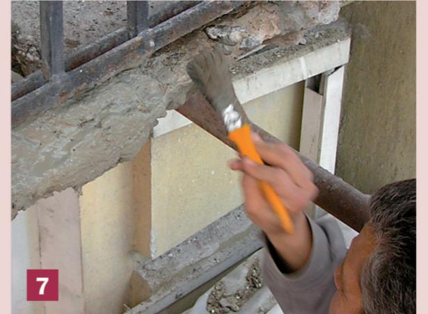
7 Înaintea aplicării mortarlui de reparații se va amorsa cu amorsă de aderență BetoHaft. Se va avea în vedere ca toate gulerile să fie astfel bine acoperite (amorsate).
