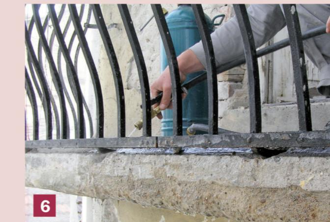
6 Pe părțile metalice (din fier) se va aplica protecția anticorozivă BetoProtect, în 2 straturi cu o pensulă cu un interval de 6 ore între straturi.
