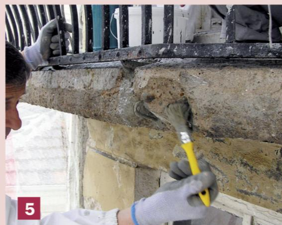
5 Pe părțile metalice (din fier) se va aplica protecția anticorozivă BetoProtect, în 2 straturi cu o pensulă cu un interval de 6 ore între straturi.
