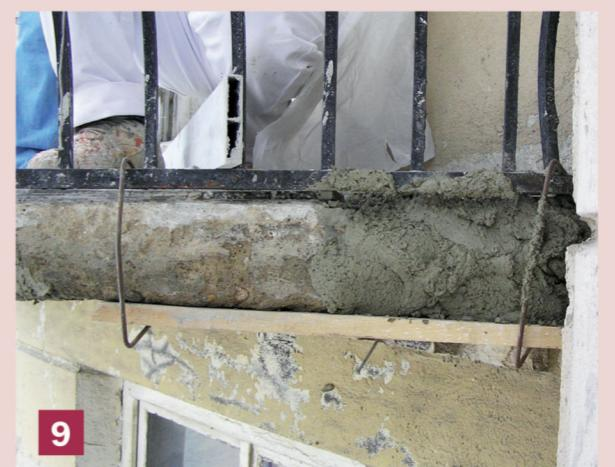
9 Pe zonele cu denivelări mari se vor aplica mai multe straturi succesive de mortar de reparatii, BetoFill cu grosimea de max. 4 cm, unde se va avea în vedere faptul că fiecare strat trebuie să se usuce timp de 1-3 ore. Se poate realiza acoperirea întregii suprafeței într-o singură etapă (în cofraj), astfel încât să se poată acoperi toată suprafața dintr-o singură etapă.
