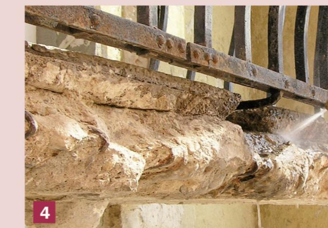
4 Cu 24 de ore înaintea aplicării mortarlui de restaurare, stratul suport se va spăla cu un jet puternic de apă, pentru a îndepărta praful și alte particule de murdărie și pentru a crea o aderență bună cu produsele Beto.
