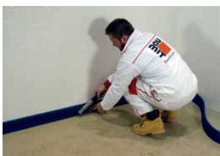
1. Montarea benzilor de etanșare
