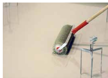
6. Dezaerarea suprafeței cu rolă cu țepi
