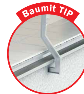
Fixați balustrada din partea laterală a plăcii
