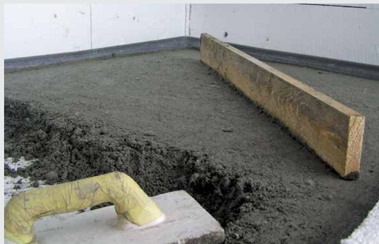
Realizarea șapei de ciment
