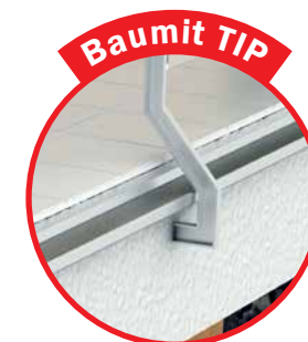
Fixați balustrada din partea laterală a plăcii
