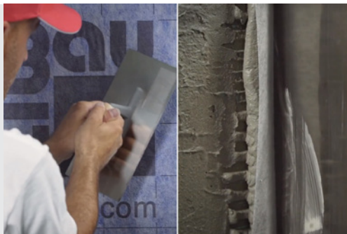
10. Fixare în adeziv Baumacol AquaSave astfel încât adezivul să refuleze la margine
