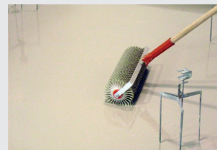
6. Dezaerarea suprafeței cu rolă cu țepi
