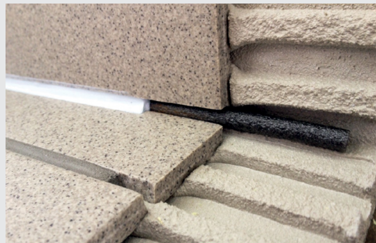
Detaliu rost dilatare
