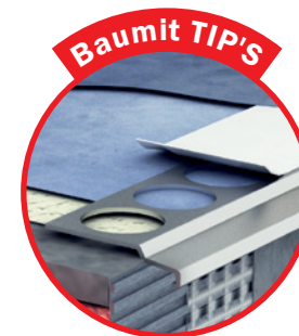
Acoperirea profilului cu bandă de etanșare
