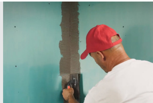
3. Aplicare adeziv pe zona de intersecție a pereților
