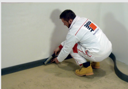
1. Montarea benzilor de etanșare
