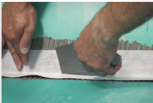
10. Fixare în adeziv Baumacol AquaSave astfel încât adezivul să refuleze la margine
