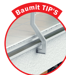
Fixați balustrada din partea laterală a plăcii
