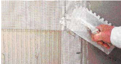
Fig. 22 Suprapunerea plasei de fibră de sticlă (min. 10 cm)
