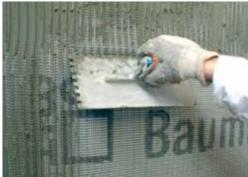
Fig. 23 Înglobarea plasei în proaspăt
