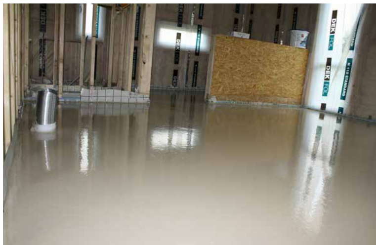
Etanșarea ferestrelor pentru 24 de ore - protecția șapei
