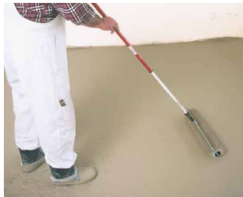
Dezaerarea sapei cu ajutorul trafaletului cu țepi
