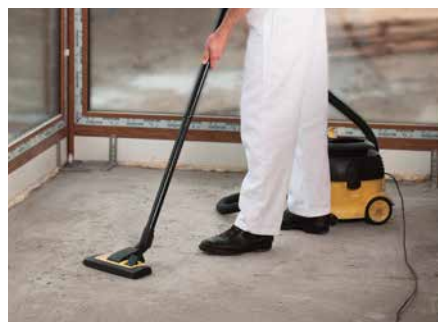
Înainte de aplicarea șapei este foarte importantă aspirarea suprafeței
