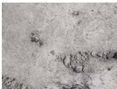
Toate suprafețele neaderente trebuie eliminate.
