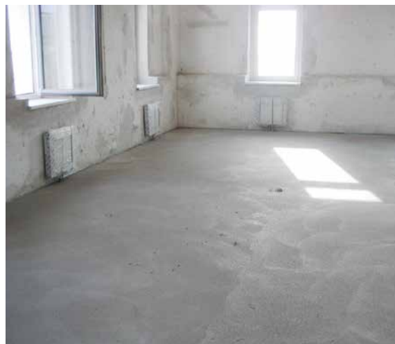
Ventilație după 24 de ore de la turnare
