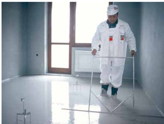
Dezaerarea cu ajutorul barei de dezaerare
