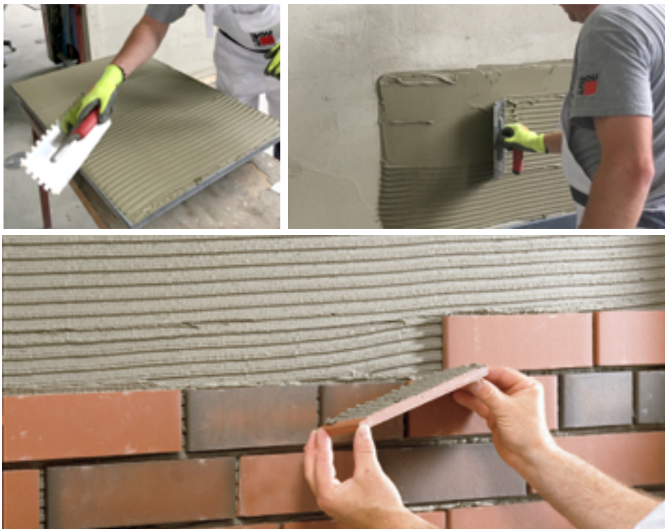
Lipire folosind metoda Buttering-Floating în cadrul sistemului Baunit CeramicFix.
