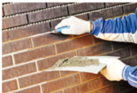
Fig.1 - Chituire cu mistria de rost
