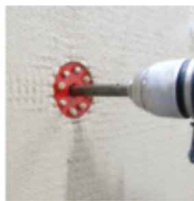
Dibluire cu Baumit S - Diblu universal cu șurub S
