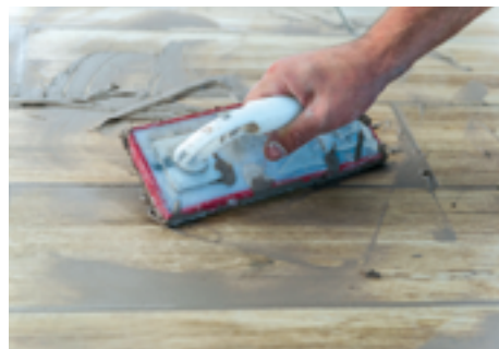
Fig.2 - Chituirea cu gletiera de cauciuc (clasic)
