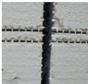
Rost tăiat în materialul termoizolant
