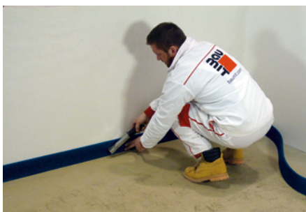
1. Montarea benzilor de etanșare
