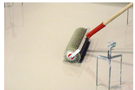
6. Dezaerarea suprafeței cu rolă cu țepi
