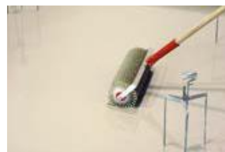
6. Dezaerarea suprafeței cu rolă cu țepi
