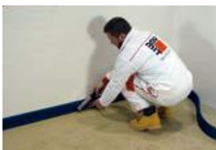
1. Montarea benzilor de etanșare
